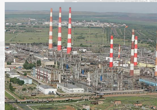
Оренбургский газоперерабатывающий завод
