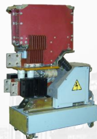
Выключатели для защиты преобразователей прокатных станов металлургических заводов и т.п.
